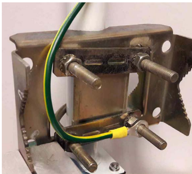
Photo 21 : Reprise de la connexion de terre sur la bride de fixation du mât
